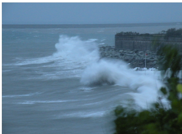
Figura 23 Mare vivo da Est, Sud-Est in atto nel pomeriggio del 4 ottobre intorno alle ore 18. L'immagine evidenzia chiaramente come il colpo di mare osservato avesse una buona capacità di penetrazione (legata a un effetto di 'surcote'), senza tuttavia evidenziare un'altezza d'onda significativa (tipica della mareggiata).
