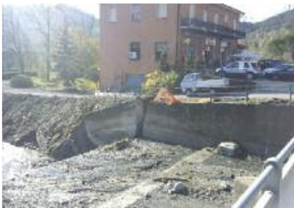
Erosione in sponda ds del Canal Grande di Graveglia a valle del ponte sulla provinciale, con scalzamento e crollo di parte del muro d'argine
