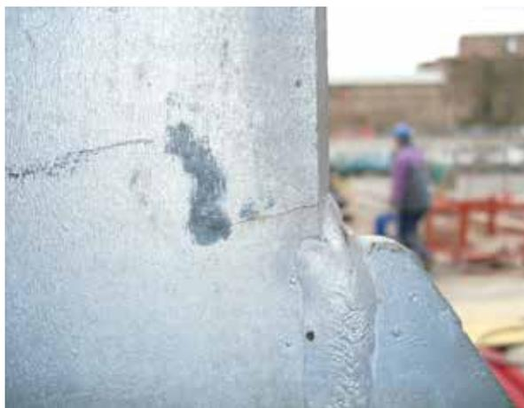
Gru a torre con una cricca in propagazione da una saldatura
